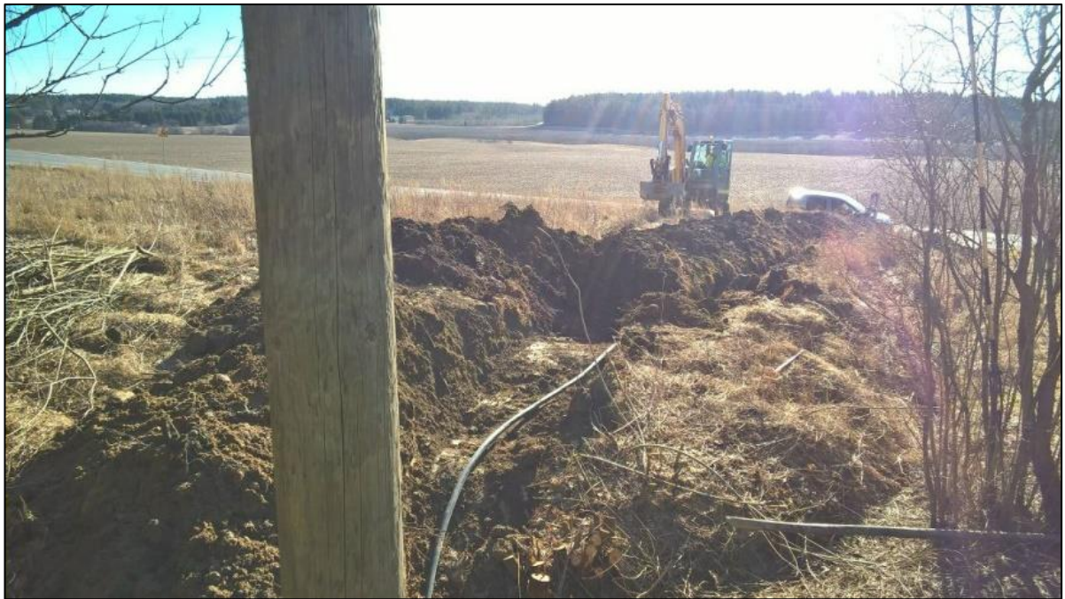
Kaivannon luoteispää (sähkötolpan kohdalla). Keskellä kuvaa osuus, joka kaivettiin suurimmillaan 1,5 m leveäksi. Luoteesta.
