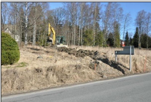
Valvotun linjan alkupiste oikealla liikenne-merkin etupuolella. Päätepiste vasemmalla näkyvän valkoisen asuinrakennuksen etupuolella. Etelästä.
